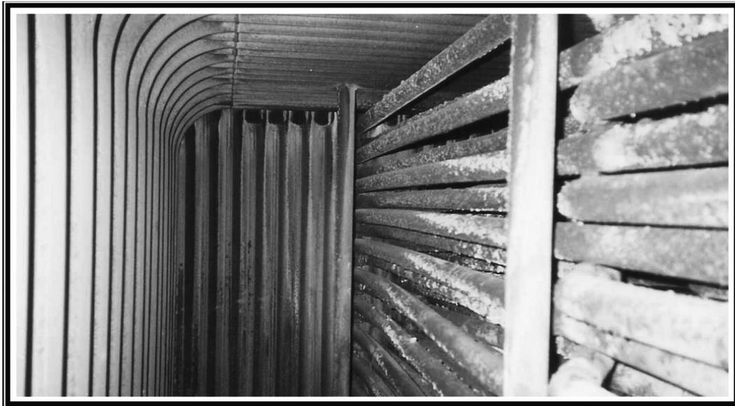
صورة (3): تآكل أنابيب المكثفات (التبادل الحراري) في محطة بنغازي للتحلية
