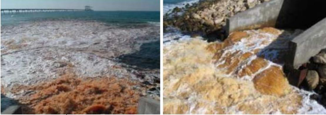
صورة (6): تصريف مياه غسيل المرشحات (ظاهرة المحلول الملحي الأحمر) Ashkelon RO plant with negatively buoyant brine discharge during backwash through an open channel at the coast into the Mediterranean.
